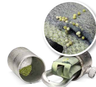
Sin mantenimiento de la climatización
